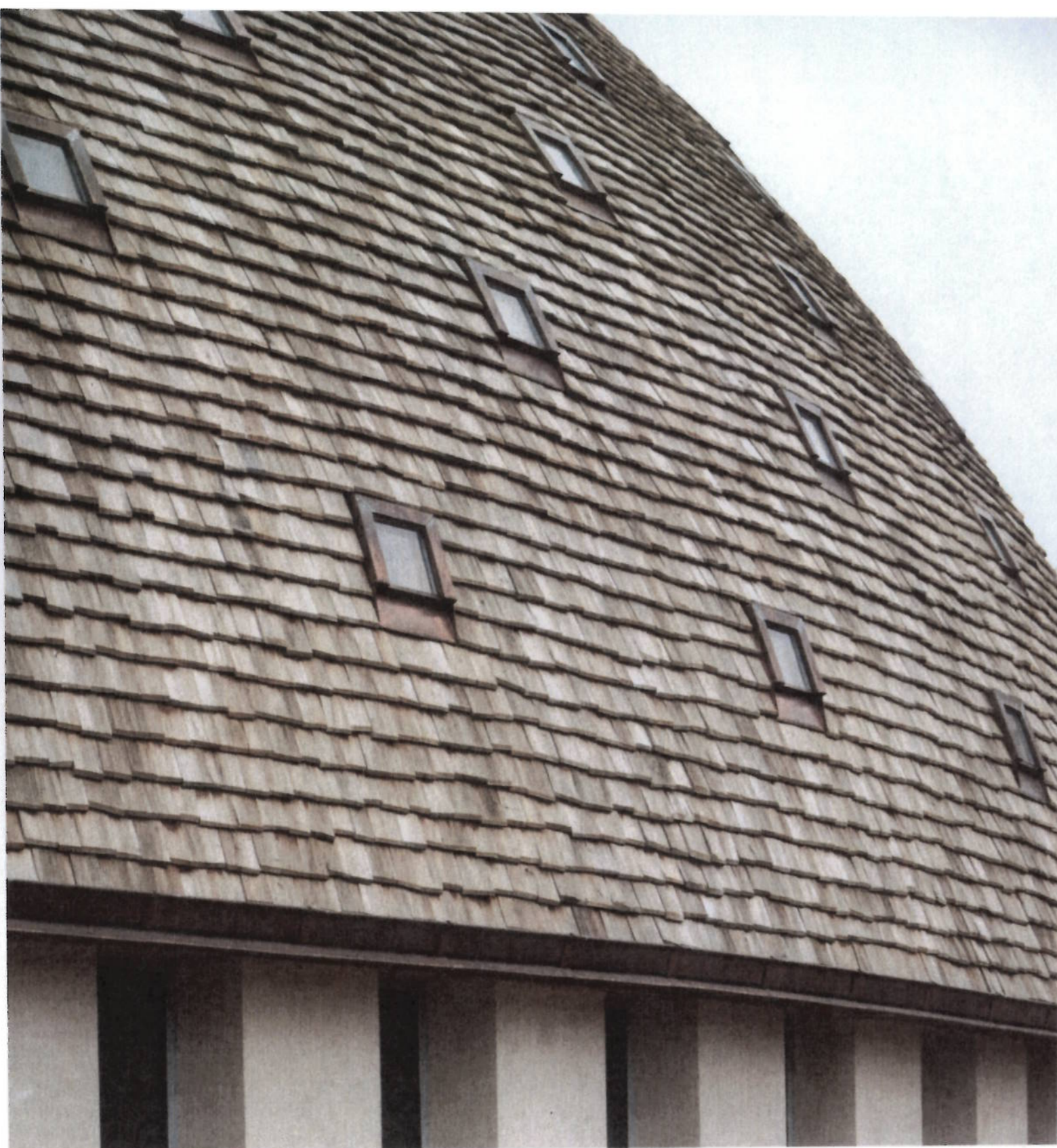
La charpente en bois est en châtaignier de la Sarthe, aux tavaillons «faits main»
